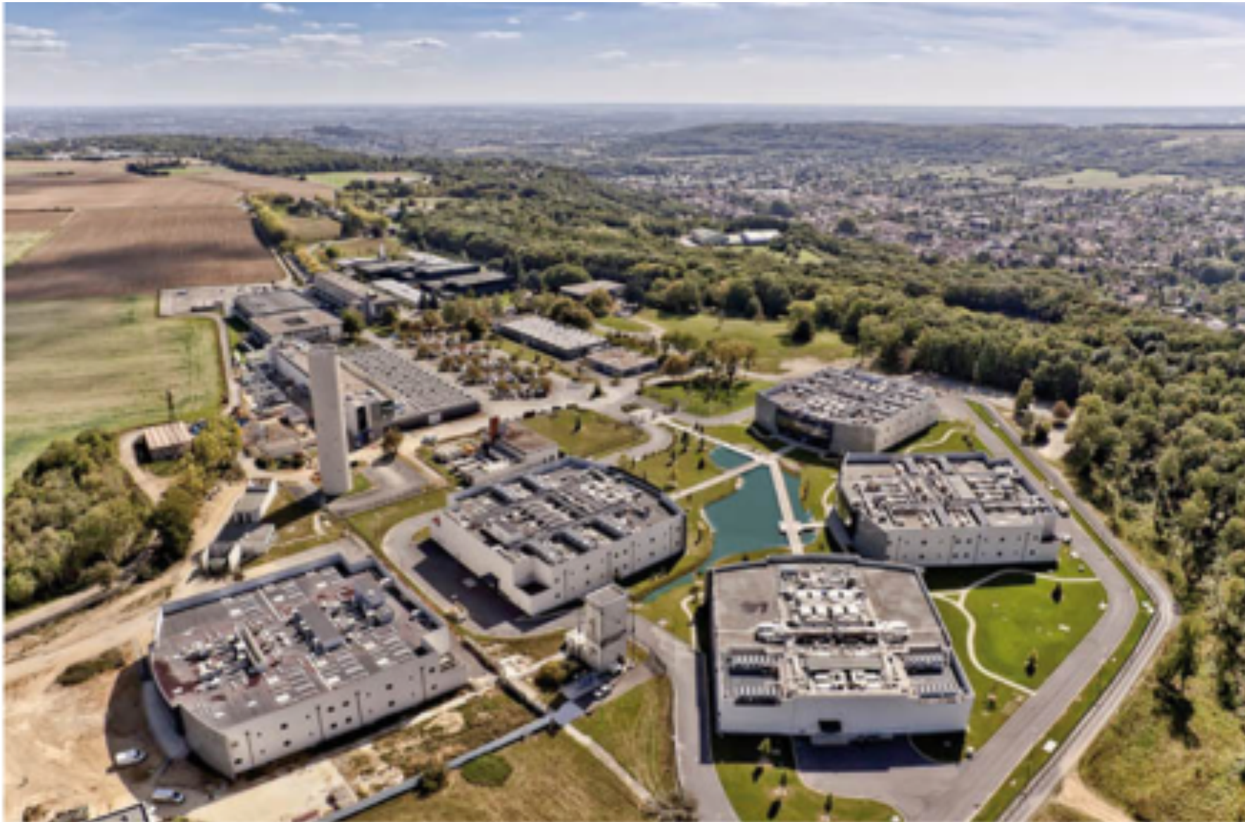
Une vue aérienne du Campus de Datacenter de DATA4, à Paris-Saclay, le plus puissant d'Europe (100 MW), relié à plus de 110 Data Destination comme AWF et Azure
